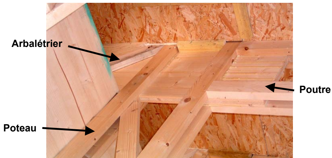
Figure 4 – Nœud de liaison d'angle de portique.
