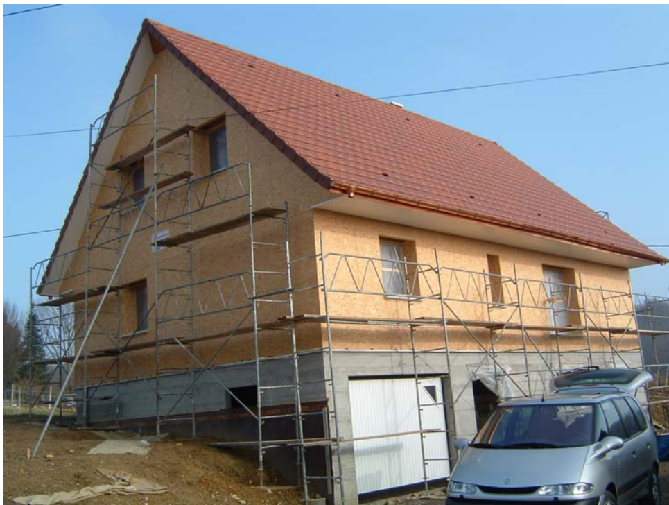
Figure 1 – Maison en construction à WALDIGHOFFEN (68).
