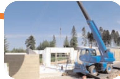
Le levage et le montage
