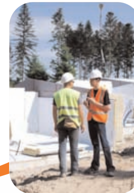
Les réunions de chantier
