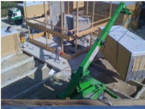
Les modules du bâtiment A sont mis en place, au même temps que les fondations du bâtiment B.
