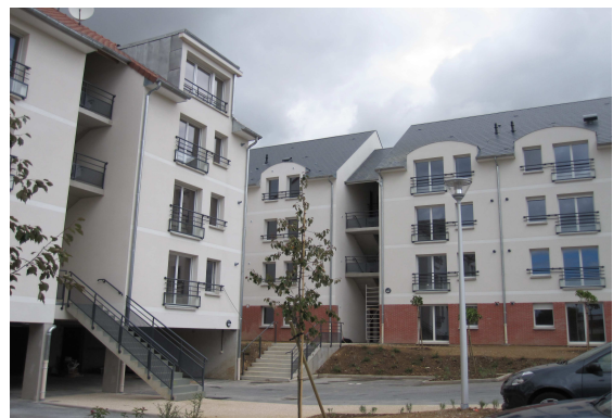
Photo opération terminée
