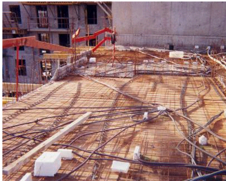
Photo pose gaines électriques sur chantier
