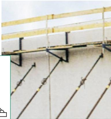
La mise en œuvre d'une plateforme périphérique de type standard gros œuvre est préconisée pour des tâches spécifiques (les réservations de fixation et la prise en compte des efforts sont à déterminer en phase de préparation de chantier), le dimensionnement des étais tirant poussant tiendra compte de la présence de la plateforme.
