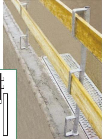
Le garde-corps peut être ancré dans l'axe du mur précoffré®, les réservations de fixation sont à déterminer en phase de préparation de chantier.
