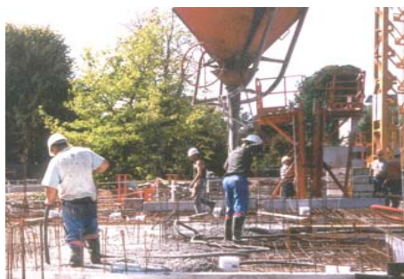
Les Terrasses des Ormeaux à Evreux (27), Maître d'Ouvrage La Construction Résidentielle (filiale de Sogea Nord Ouest).
