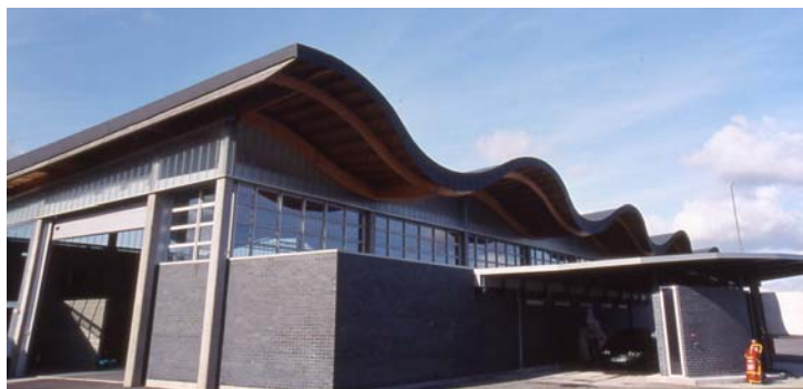
Centre d'entretien, Gendarmerie à Yvetot (76). Architectes Badia et Berger.
