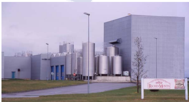
Fromagerie LE LUTIN à Pacé (61). Maître d'Ouvrage SODIAL, Maîtrise d'Oeuvre Ussy. Reconstruction d'une unité de production de 20 000 m 2 en 4 mois à la suite d'un incendie.
