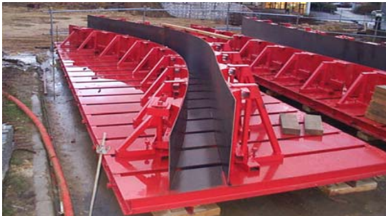
Moule pour poutres courbes (Ingénierie : méthodes Sogea Nord Ouest Caen).
