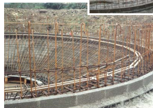
Fond de bassin, station d'épuration et de traitement EMERAUDE à Petit Quevilly (76), Maître d'Ouvrage S.I.A.R.R. Rouen
