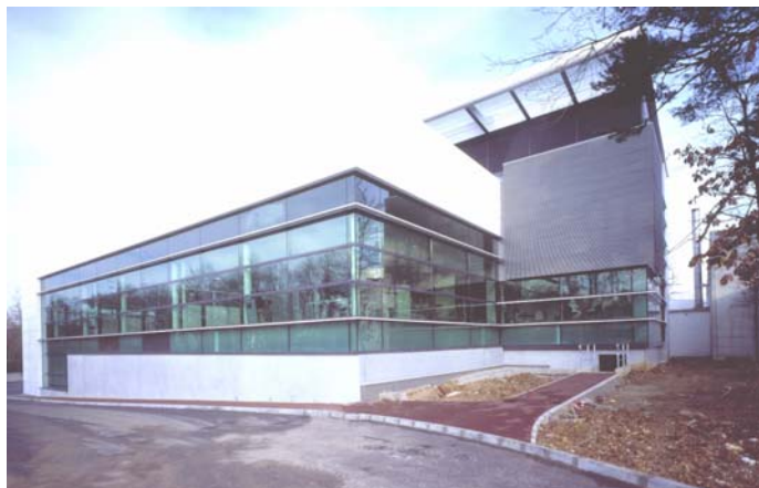
Laboratoire pharmaceutique à EVREUX (27)
