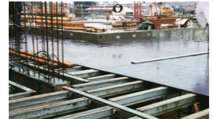
Coffrage pour plancher.
