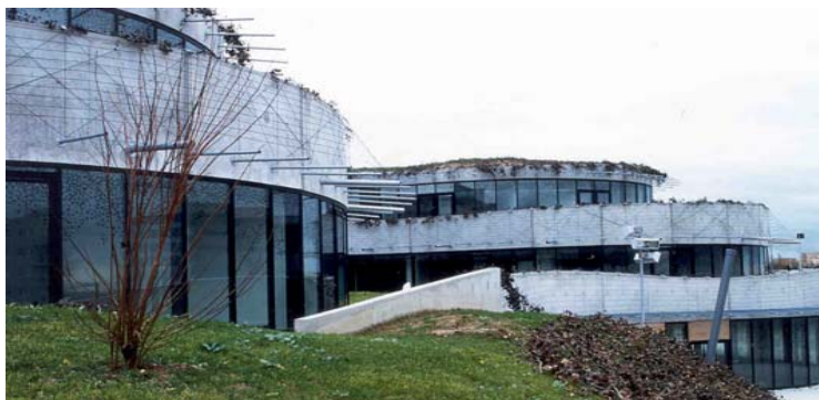
Direction Régionale du Travail, de l'Emploi et de la Formation Professionnelle à Hérouville Saint Clair (14), maître d'ouvrage SHEMA, architectes : Jean NOUVEL et ROUX & ALBA
