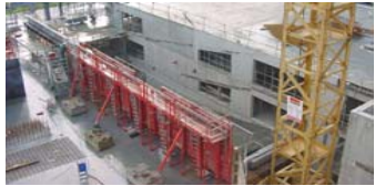
Coffrages pour voiles (banches).
