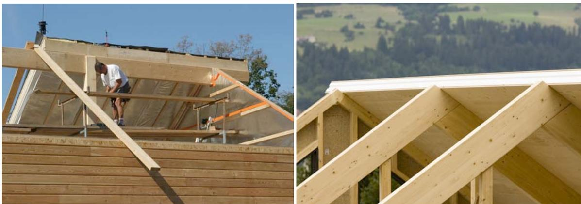
Pose de la charpente avec système de panneaux toiture de grande dimension apportant gain de temps, finition intérieure, sécurité et garantissant une isolation thermique performante.
