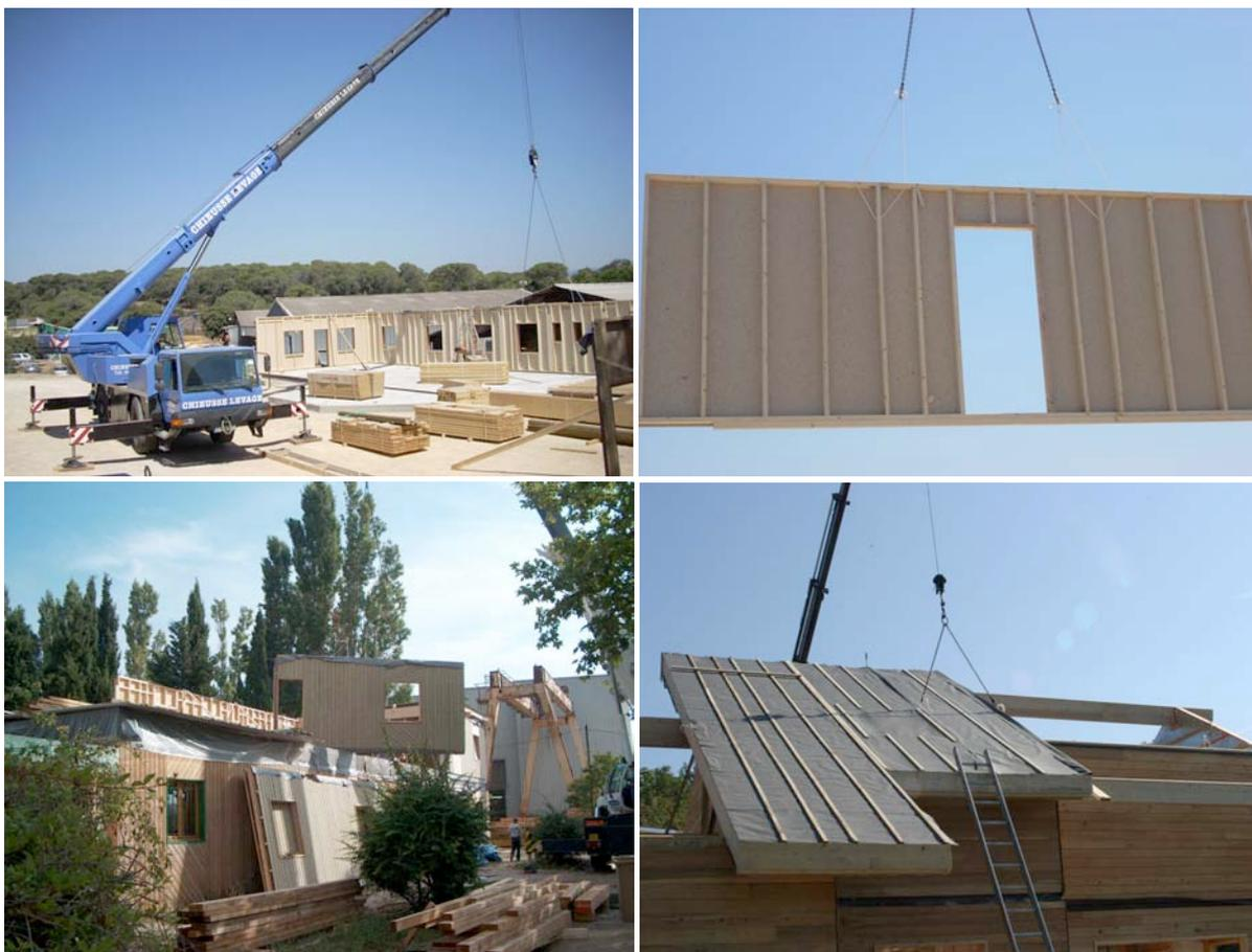
La pose de murs préfabriqués avec bardage et isolant permet de limiter le temps d'intervention et garantit la sécurité du chantier.
