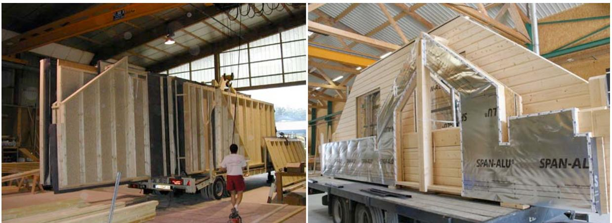
Les panneaux sont ensuite livrés en plus ou moins grande dimensions (de 1.20 m à 9m) selon l'accessibilité du chantier et les moyens de levage mis à disposition. Cette technique nous permet d'optimiser les transports et donc l'impact sur l'environnement, mais aussi de s'adapter à la typologie et la spécificité de chaque opération, atout primordial pour les opérations de surélévation et d'amélioration des logements existants.
