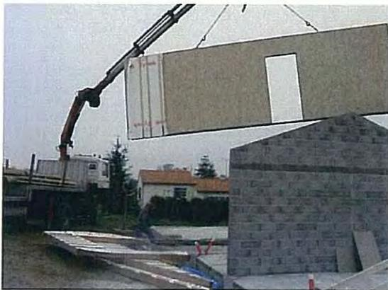
*Levage des panneaux d'ossature par grues adaptées aux chantiers. Les panneaux d'ossature sont revêtus extérieurement d'enduit ou d'un bardage.*
