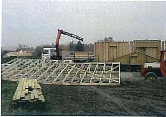
*Avant la pose de l'ossature, les fermes industrielles sont assemblées au sol et contreventées.*
