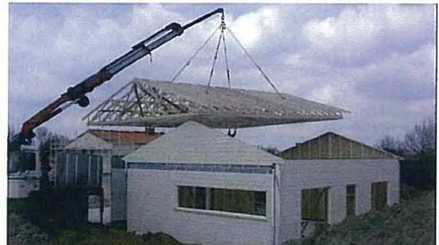
*Après la pose de l'ossature, le bloc de fermes industrielles est repris à la grue et positionné sur l'ossature. Ce type de procédé diminue le risque d'accidents du travail. Pratiquement pas de travail en hauteur.*
