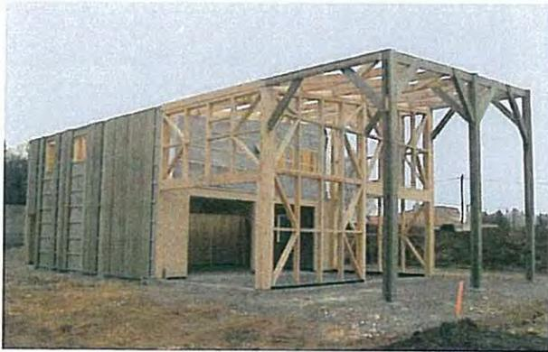
*Vue d'ensemble de la structure, au premier plan le préau avec le portique en Kerto-Q, le jardin d'hiver, puis l'habitation avec le bardage bois vertical à recouvrement, au fond, le garage et le grenier.*
