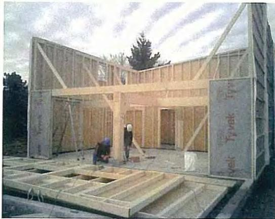
*Mise en œuvre de la structure porteuse en lamellé collé GL 32, dans la partie habitat. Le plancher d'étage en lamibois de 69 mm d'épaisseur, posé sur les poutres, apporte plusieurs réponses au maître d'ouvrage : performance, rationalité et économie.*
