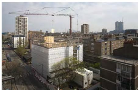
Grâce à une fabrication et un découpage précis des panneaux en usine, le bâtiment a été livré en 49 semaines au lieu de 72 prévues s'il avait été construit avec une structure classique en béton armé. Ce bâtiment étant le premier en son genre, les délais peuvent être encore améliorés. En optimisant le séquençage un bâtiment similaire pourrait être livré en 37 semaines pour un budget de 1606 euros du mètre carré habitable.
