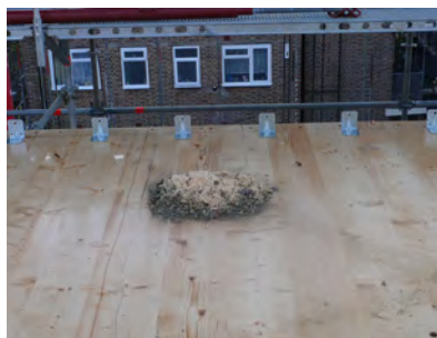
Déchet d'une semaine de chantier !
