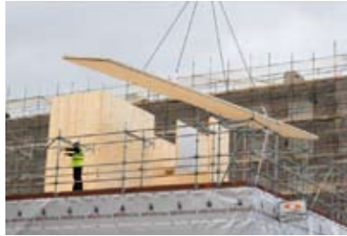
INSTALLATION PAR GRUE
