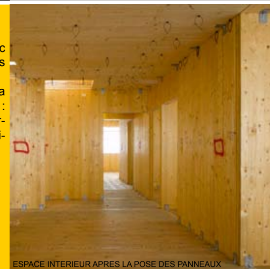
ESPACE INTERIEUR APRES LA POSE DES PANNEAUX
