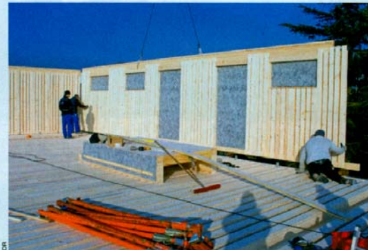
Pose des murs et des planchers bois de la résidence du Cèdre (24 logements).
