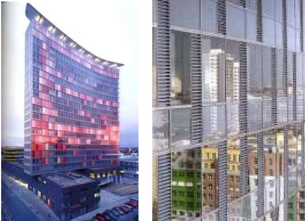
Le quatrième exemple est également un bâtiment qui a fait l'objet d'une réflexion globale visant à conférer aux deux façades des fonctions complémentaires dans le traitement de la ventilation. En l'occurrence, l'air est introduit par la façade nord et rejeté par la façade
