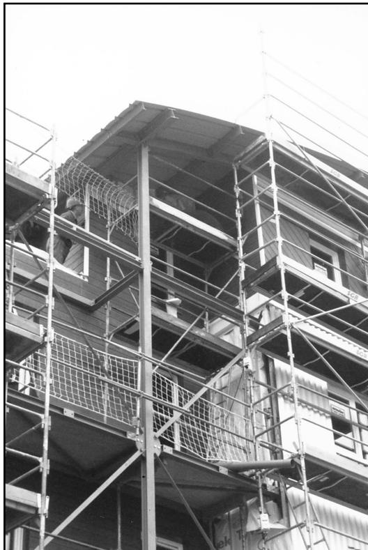
Comme l'opération expérimentale de St Martin d'Hères<sup>1</sup> dont elle est un prolongement, la REX d'Evreux a pour but de mettre en œuvre un plancher à structure métallique, baptisé PCIS (Plancher Composite Interactif Sec), développé conjointement par le cabinet d'architectes Dubosc et Landowski et les industriels Hairoville, Isoroy, Lafarge et Saint Gobain.
