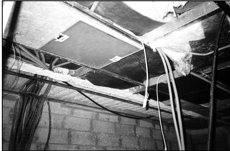
Cette opération de 48 logements située à Paris avait pour objectif de poursuivre le développement du plancher composite interactif sec (PCIS)<sup>1</sup> en généralisant le passage des réseaux dans le vide du faux plafond et en y intégrant un système de chauffage par plafond rayonnant.
