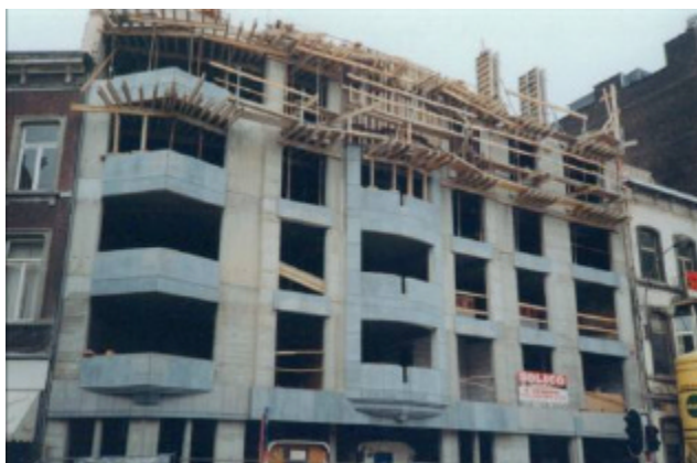
Belgique : exemple de méthode de coffrage en résidentiel collectif
