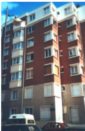
« Ceinture rouge parisienne » (période 1920-1930) : noter les poteaux en angles de fenêtres
