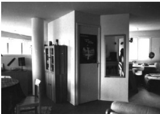
Intérieur de logement avec poteau désolidarisé du cloisonnement
