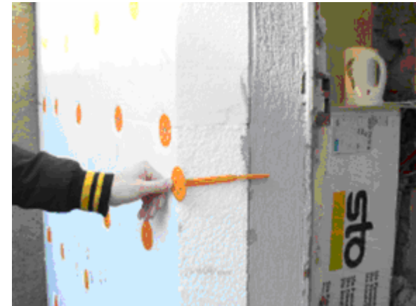
15 cm Isolation par l'extérieure Source quartier Franklin à Mulhouse
