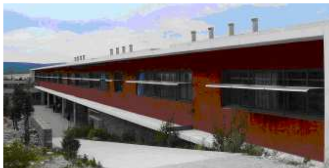
Étagère de lumière, source: lycée du pic Saint Loup
