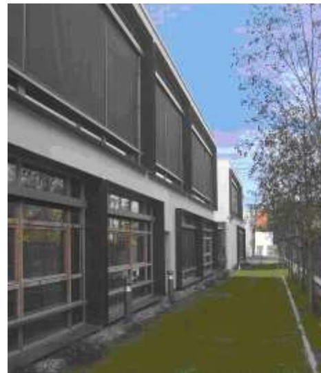
Protections solaires source : Lycée Sampaix
