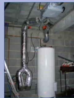
La température de sortie de puits varie de 6°C à 19°C
