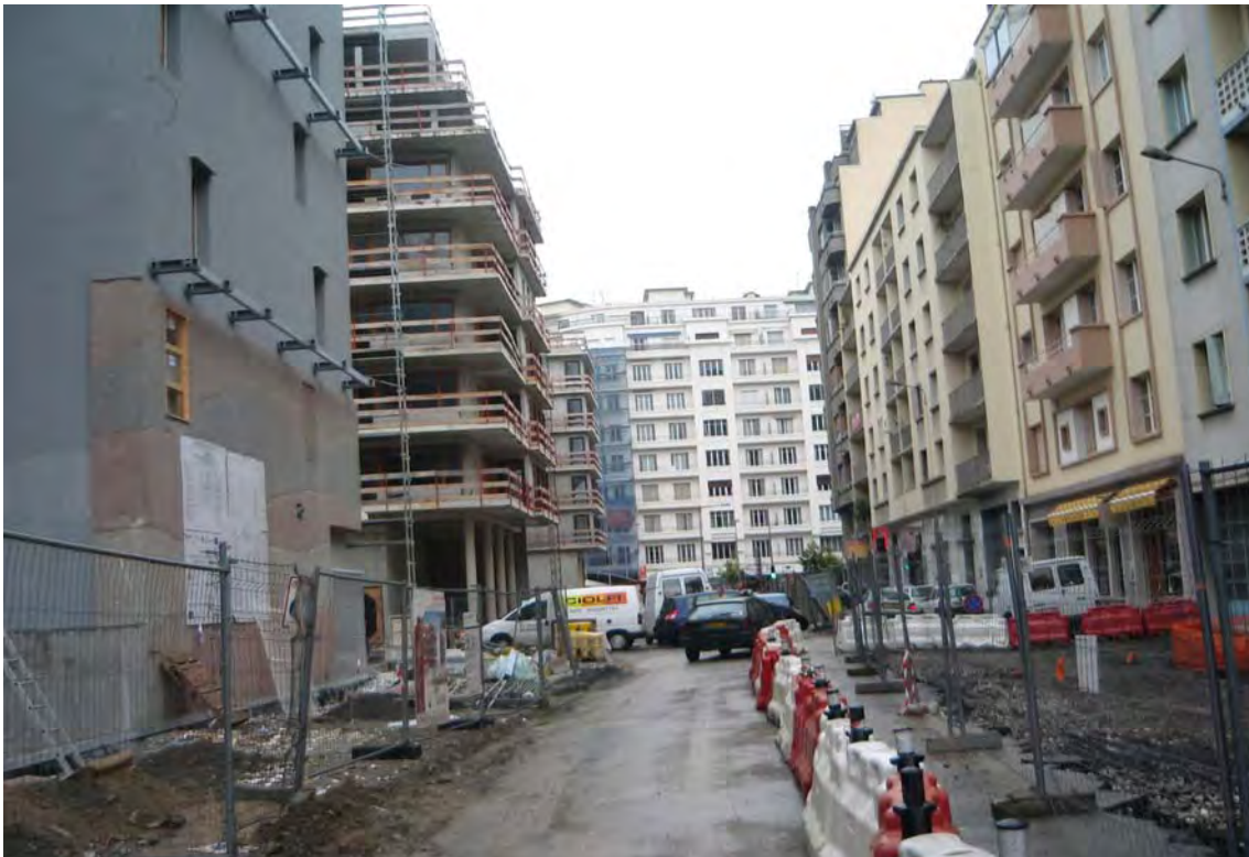
La ZAC en chantier © Jacotte Bobroff
