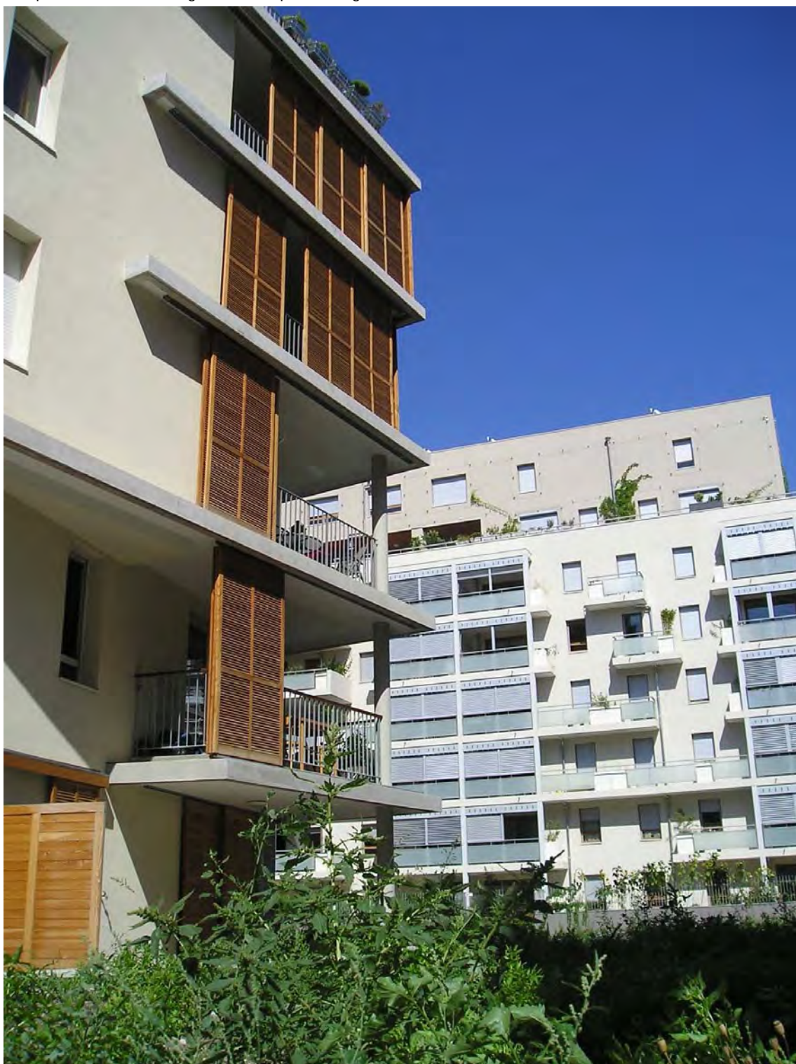
L'opération de 38 logements en accession à la propriété d'ICADE (bâtiment de gauche) – architectes : cabinet Félix Faure / Macary / Page © SEM SAGES
