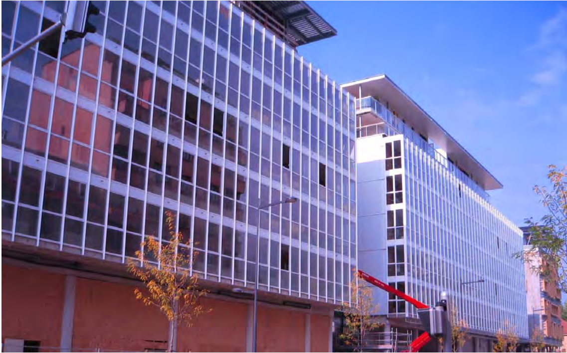
L'opération de 121 logements en accession à la propriété de Nexity – architecte Jean-Paul Viguier © Jacotte Bobroff
