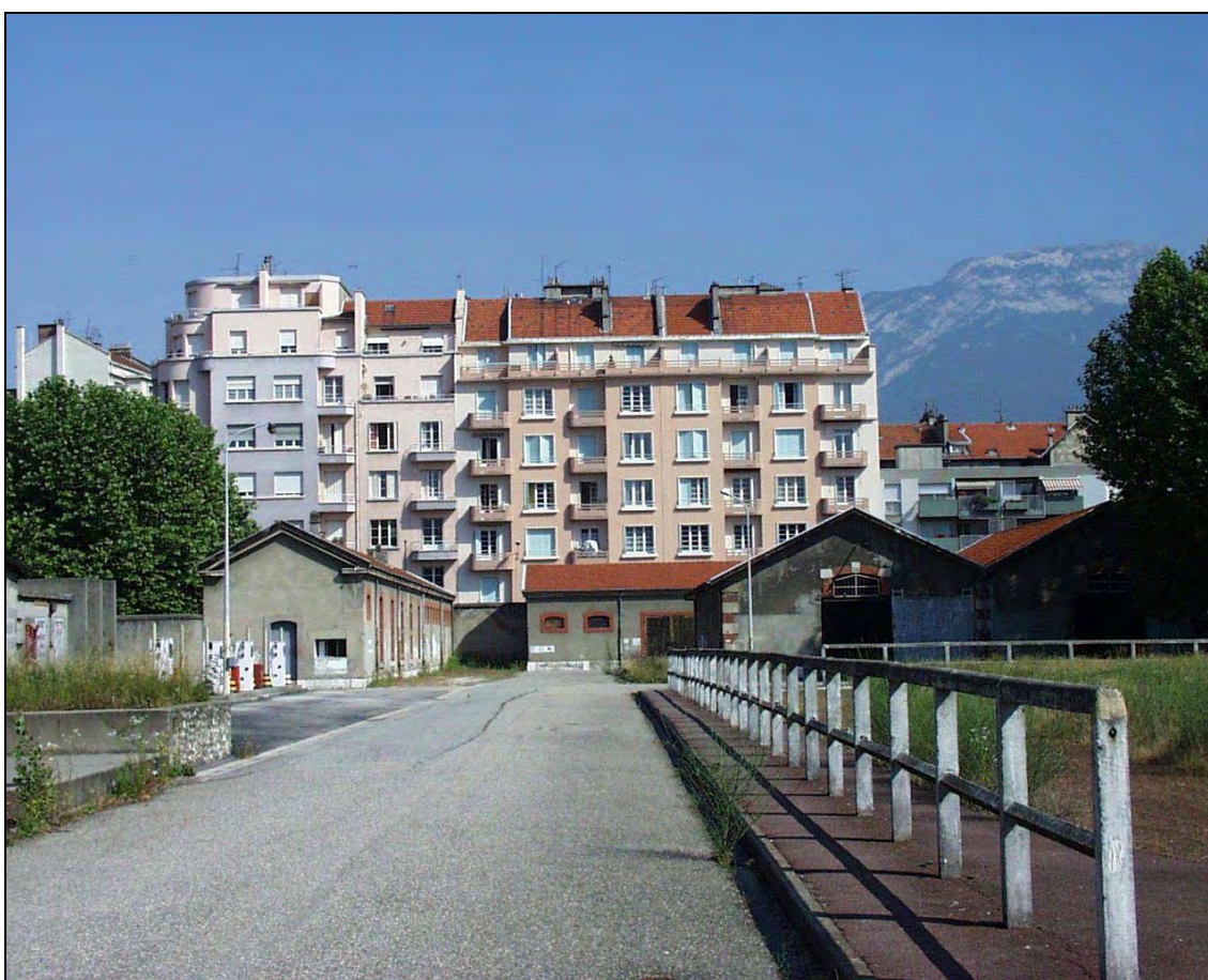
La ZAC de Bonne avant travaux © SEM SAGES
