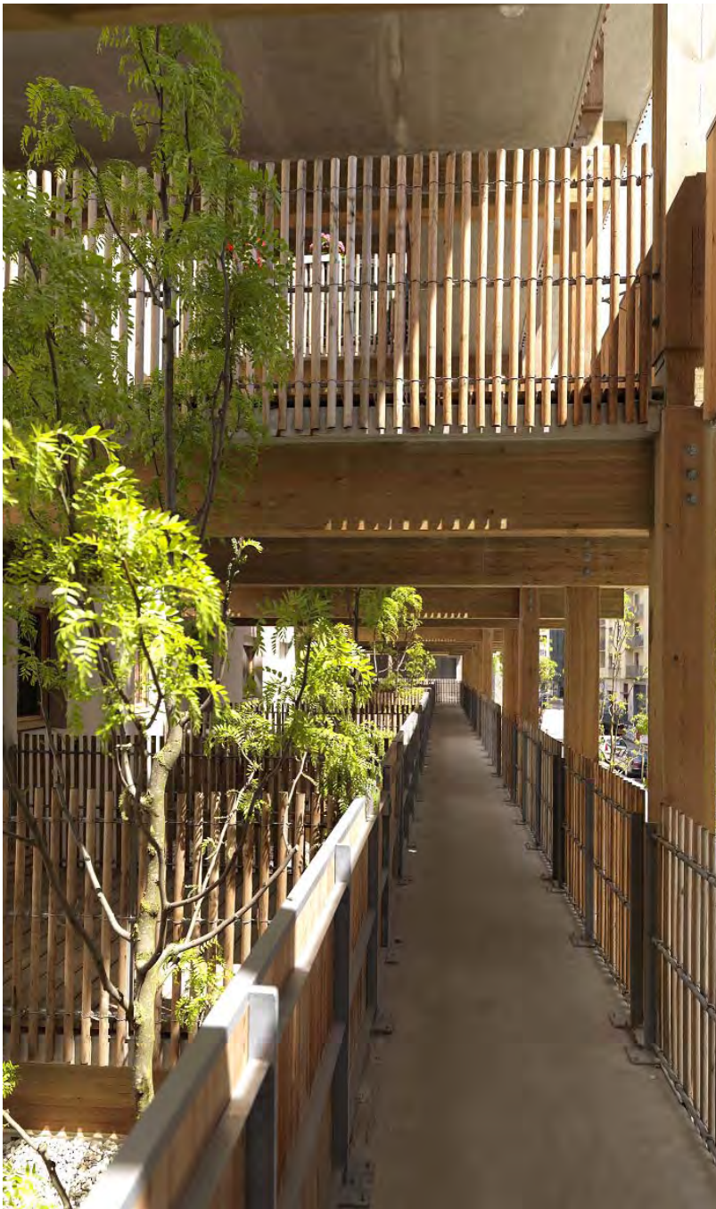
Détail des coursives de desserte des logements de l'opération de 52 logements collectifs sociaux de l'OPAC 38 - Architecte Edouard François © SEM SAGES
