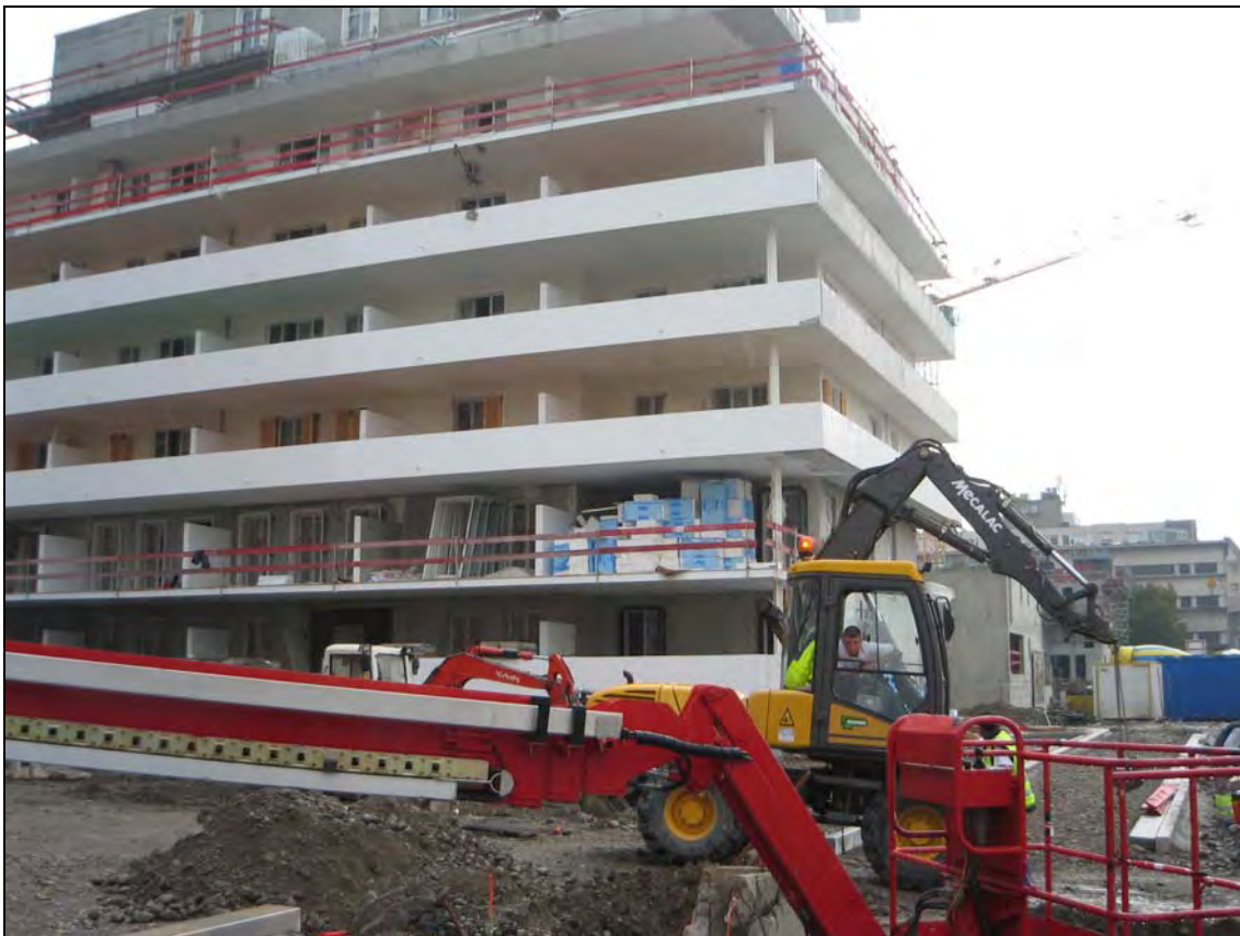
La ZAC en chantier © Jacotte Bobroff
