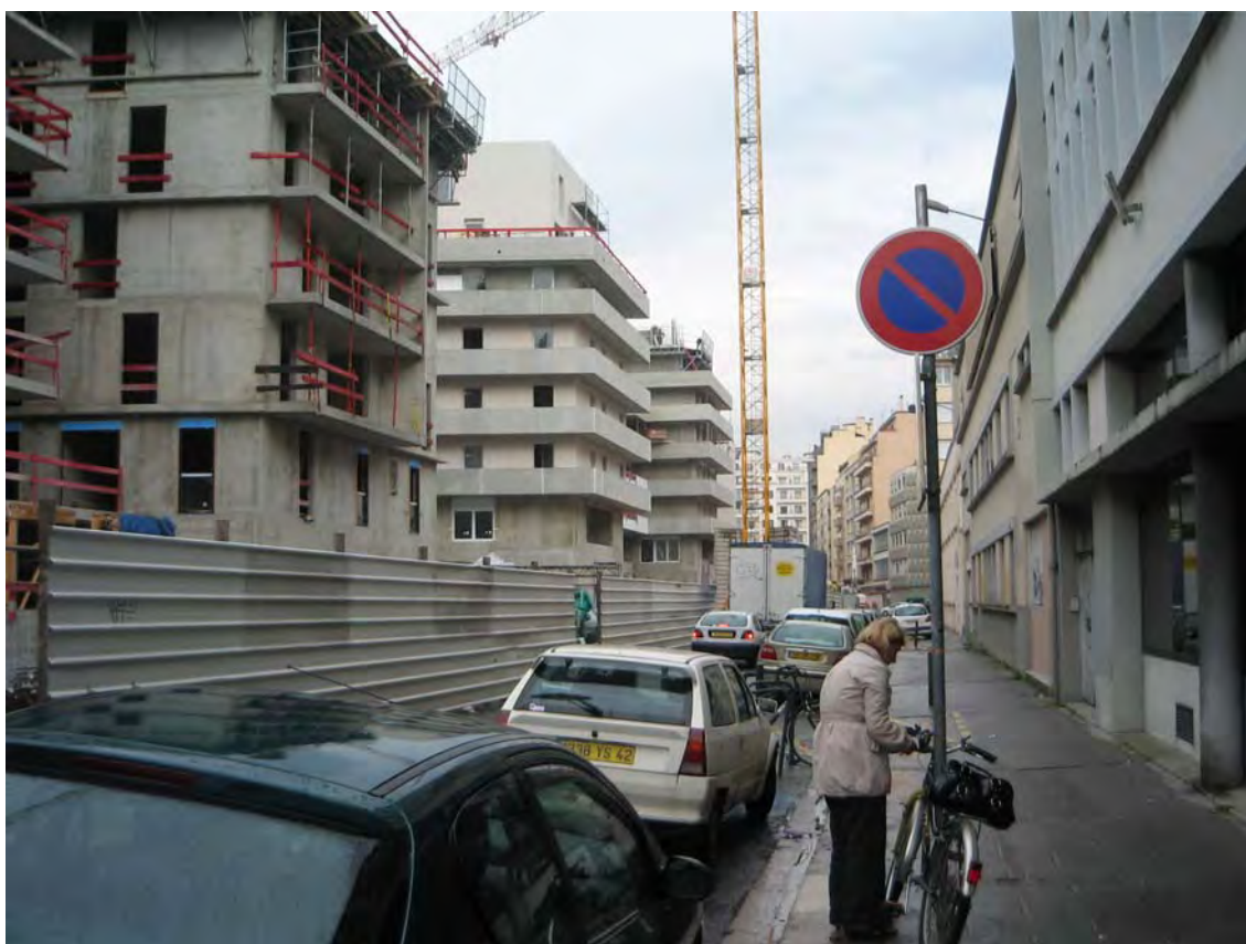
La ZAC en chantier © Jacotte Bobroff
