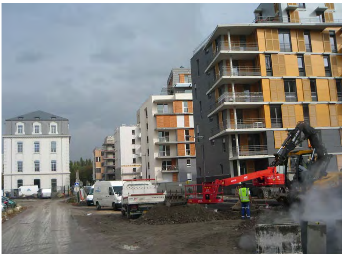
La ZAC en chantier © Jacotte Bobroff
